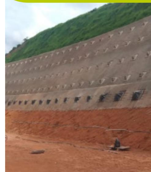
Construcción de dados prefabricados para anclajes, eliminando el vaciado en sitio y reduciendo los tiempos de ejecución al industrializar el proceso.
