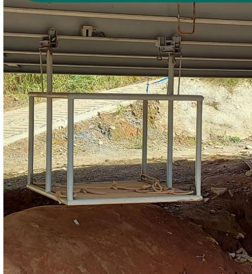
Construcción de un sistema de andamio colgante o plataformas suspendidas de nivel fijo que facilita trabajos livianos ejecutados a gran altura.
