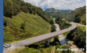
Puente Tapias UF4
