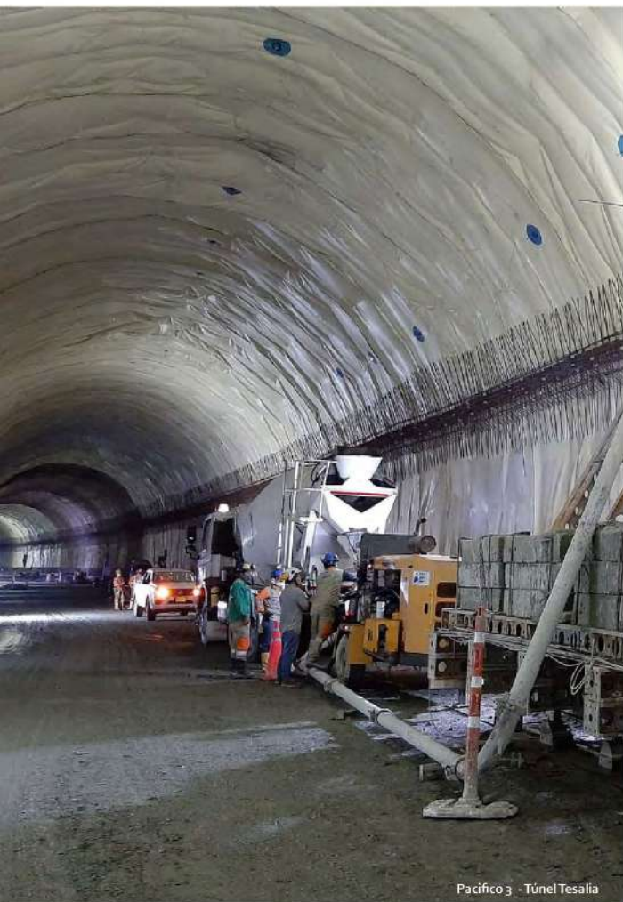
Pacífico 3 · Túnel Tesalia
