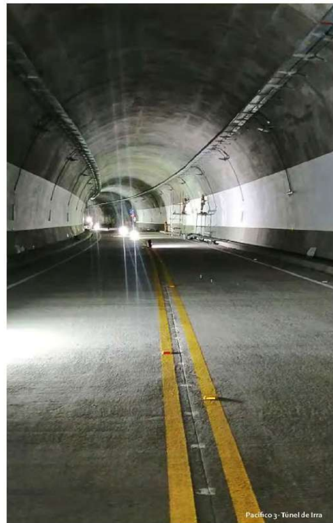
Pacífico 3- Túnel de Irra
